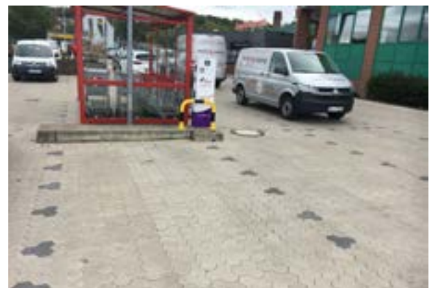
Noch fehlen die Bodenmarkierungen, aber die Station ist in Betrieb und kann genutzt werden.
